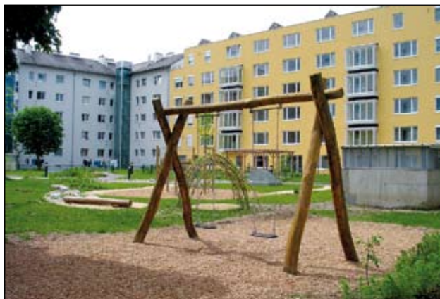
Abb. 13: Der Kinderspielbereich eingebettet in Wildstaudenzonen. Ganz rechts und ganz links im Bild die beiden Tiefgaragenabgänge, dazwischen mit Schrägabdeckung zwei kombinierte Licht- und Luftschächte.
