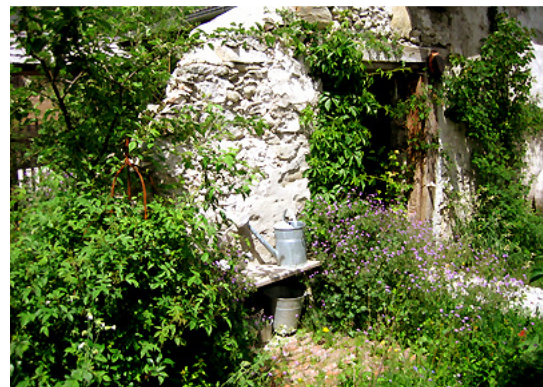
6. 2 Jahre (Frühl.) nach Fertigstellung – 30.5.2008
