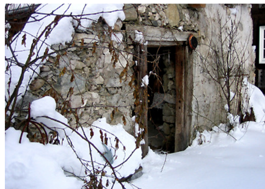
8. 3 Jahre (Winter) nach Fertigstellung – 18.2.2009
